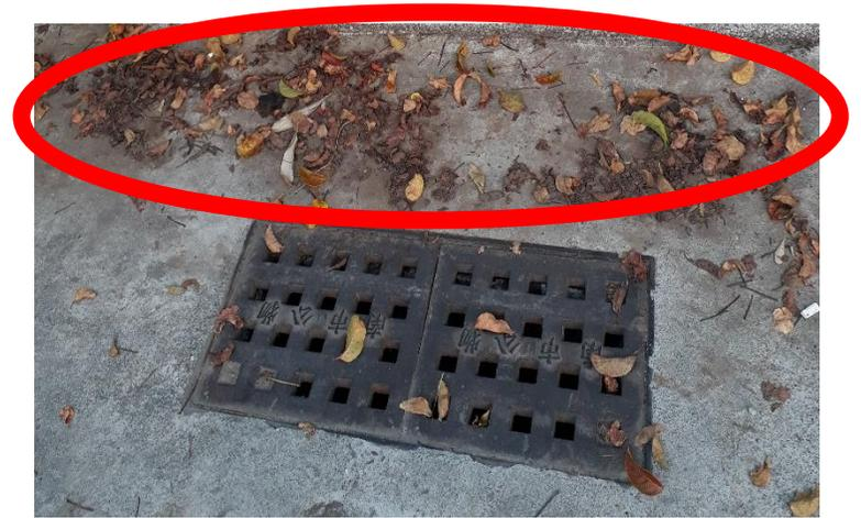
現有的排水溝容易被沙土和落葉堵住，也會有很多垃圾從水溝蓋上的孔洞掉進水溝裡，造成排水效率不佳，還是很容易淹水。
